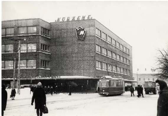
20.attēls. Tirdzniecības nams “Kurzeme” un 1961. gadā uz Liepāju atvestais modeļa T59E tramvaja vagona bez piekabes. 1968 (Ilmāra Ādamsona foto)
