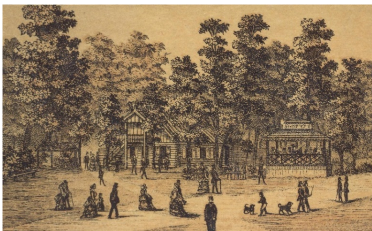
7.attēls. “Šveiciešu stila” paviljons atpūtai Pilsētas parkā (LM-3)
