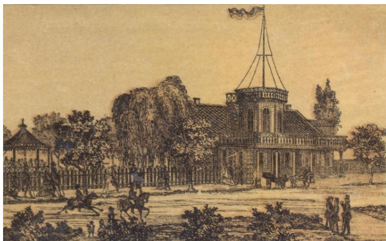
5.attēls. Paviljons Aleksandra ielas malā (LM-1) Figure 5 The pavilion at the edge of Alexander Street
