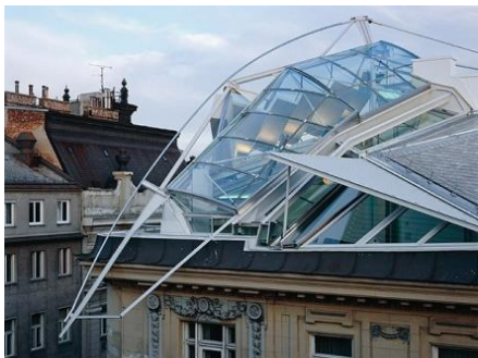
4. attēls. Coop Himmelb(l)au Jumta pārbūve. ( https://www.pinterest.com/1ww6b5ojw0g2l4y/parasite-arq/ ).
