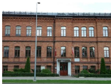
6. attēls. Daugavpils, Poļu valsts ģimnāzijas ēka, Varšavas ielā 2. Foto: J. Keiviša.
