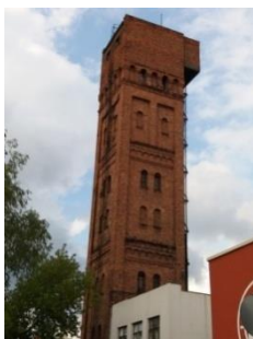
7. attēls. Daugavpils, Skrošu rūpnīca, Varšavas ielā 28. Foto: J. Keiviša.
