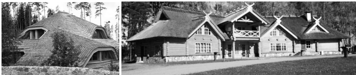
13. attēls. Dzīvojamās ēkas jumts ar koka segumu Amatciemā. ( http://amatciems.lv/lat/galerija/majas.html?pic=941 ).
