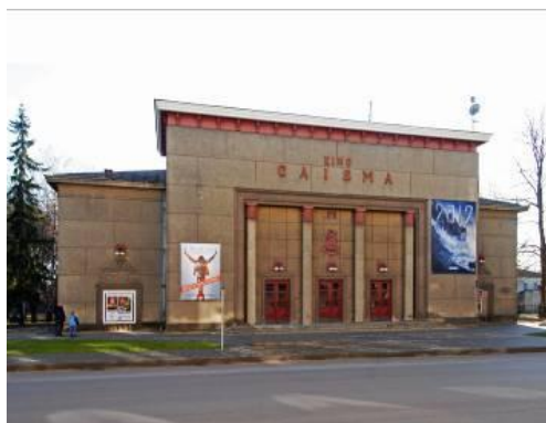
3. attēls. Kinoteātris “Gaisma”. Valmiera. Rīgas ielā 19. (1951). Arh. B. Nesterjuks. ( http://e.znet.lv/Arhitekt_stili_Latvija_Text.pdf ).
