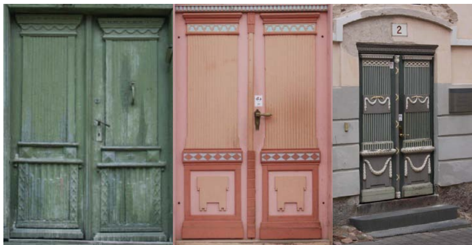
35., 36. un 37. attēls. Viengabala ārdurvju vērtnes ar dalījumu divās daļās Kuldīgā, Kalna ielā 15 (SO), Tartu Rotaļlietu muzeja ēkai (SO) un Tartu, Kuutri ielā 2 (SO)
