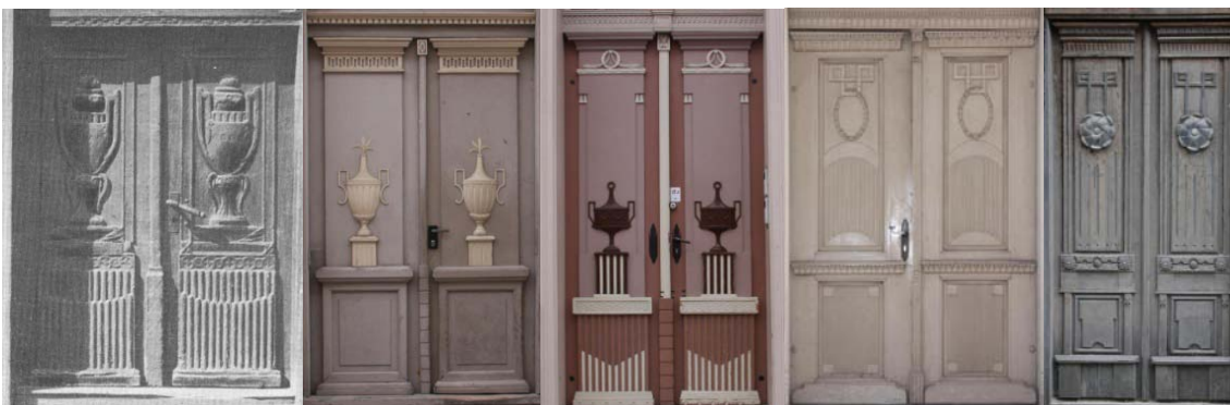
38., 39. un 40. attēls. Viengabala ārdurvju vērtnes ēkai Jelgavā, Lielajā ielā 76 (gājušas bojā) (Jansons, 1982: 89) un Tartu, Ūlikooli ielā 21 (SO) un Tampere mājai Jaani ielā 4 (SO) 41. un 42. attēls. Rāmja konstrukcijas ārdurvju vērtņu pāris Ventspilī, Kārļa ielā 5 (SO) un kombinētas konstrukcijas ārdurvju vērtņu pāris Kuldīgā, Jelgavas ielā 17 (SO)
