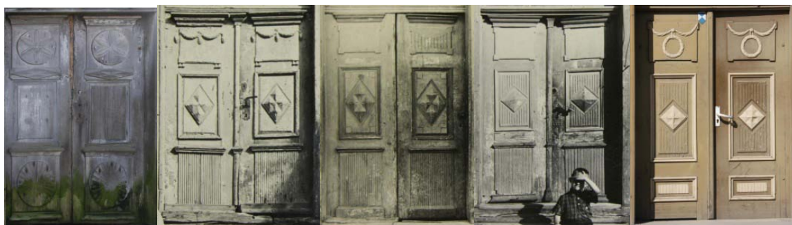
30., 31., 32., 33. un 34. attēls. Trīsdalījuma ārdurvju vērtņu pāris Aizputē, sētas mājai Jāņa ielā 10 (SO), trīs neidentificētām ēkām (VKPAI) (nav saglabāts) un Grota namam Atmosdas ielā 31 (SO)
