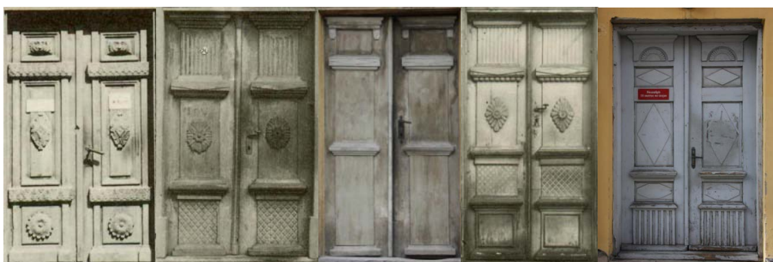
43., 44. un 45. attēls. Dzīvojamās ēkas arhaiskas trīsdalījuma ārdurvju vērtņu pāris Kuldīgā, Liepājas ielā 17 (dekors pēc durvju atjaunošanas saglabāts daļēji) (BCB), Kalna ielā 23 (BCB) un Ventspils ielā 23 (SO) 46. un 47. attēls. Dzīvojamās ēkas arhaiskas ārdurvju vērtnes ar dalījumu četrās daļās Kuldīgā, Kalna ielā 13 (BCB) un Ventspilī, Tīrgus ielā 7 (SO)
