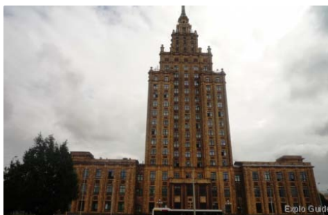
7. attēls. Rīga, Latvijas Zinātņu akadēmijas ēka Akadēmijas laukumā 1. 1953.-1958. Arhitekti: O. Tīlmanis, K. Plūksne, V. Apsītis u.c. ( http://www.panoramio.com/user/5190065/tags/R%C4%ABga )
